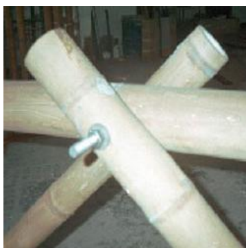
Figura 3.34: unión con tornillos Gutiérrez-Gómez
