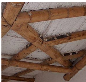
Figura 3.12: Empernado con pletinas en acero
