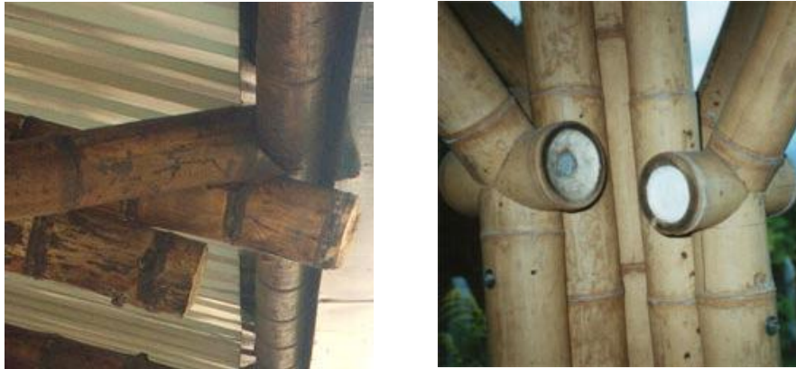
Figura 3.18 Corte Boca de pescado
