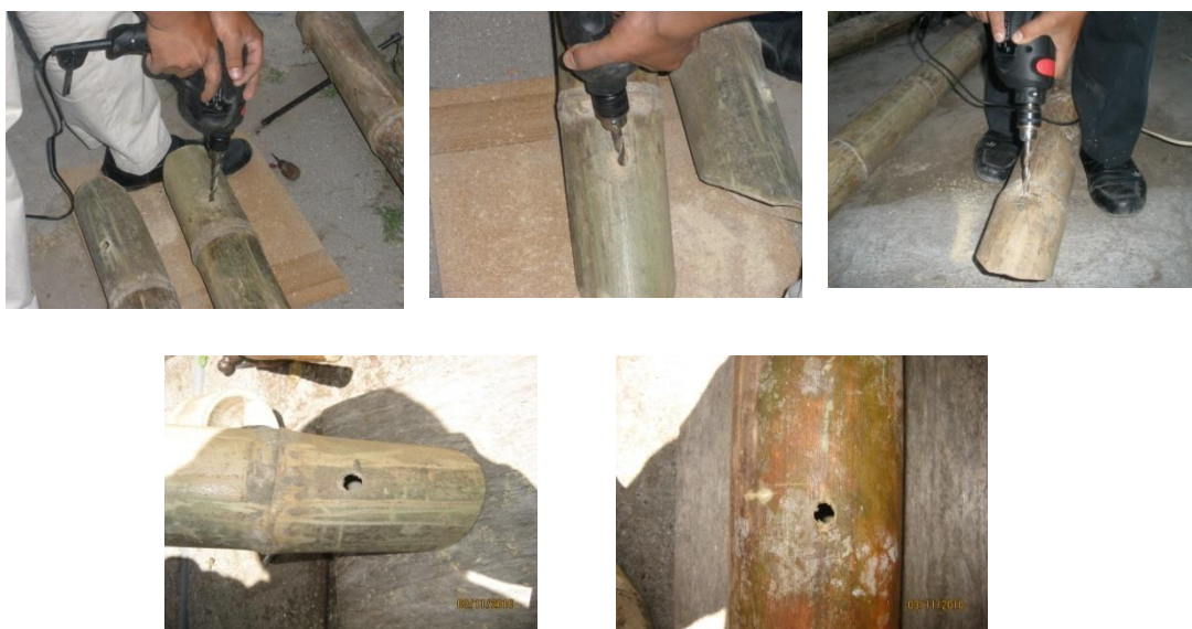
Figura 4.12: perforaciones realizadas a la caña
