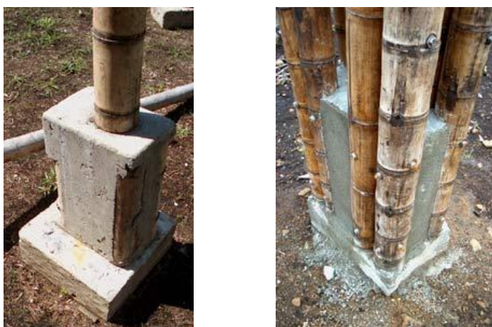
Figura 3.13b. Unión columna cimient
