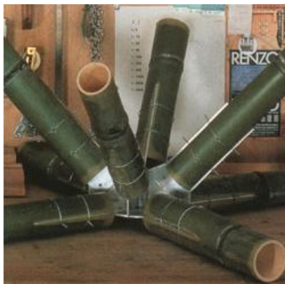
Figura 3.33: unión con platina – R.Piano
