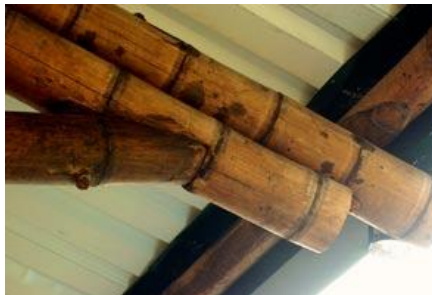
Figura 3.30: Conexión con empate frontal con antepecho
