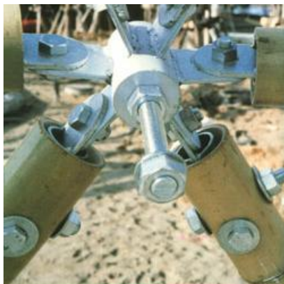
Figura 3.35: unión con tornillos – S.Yoh
