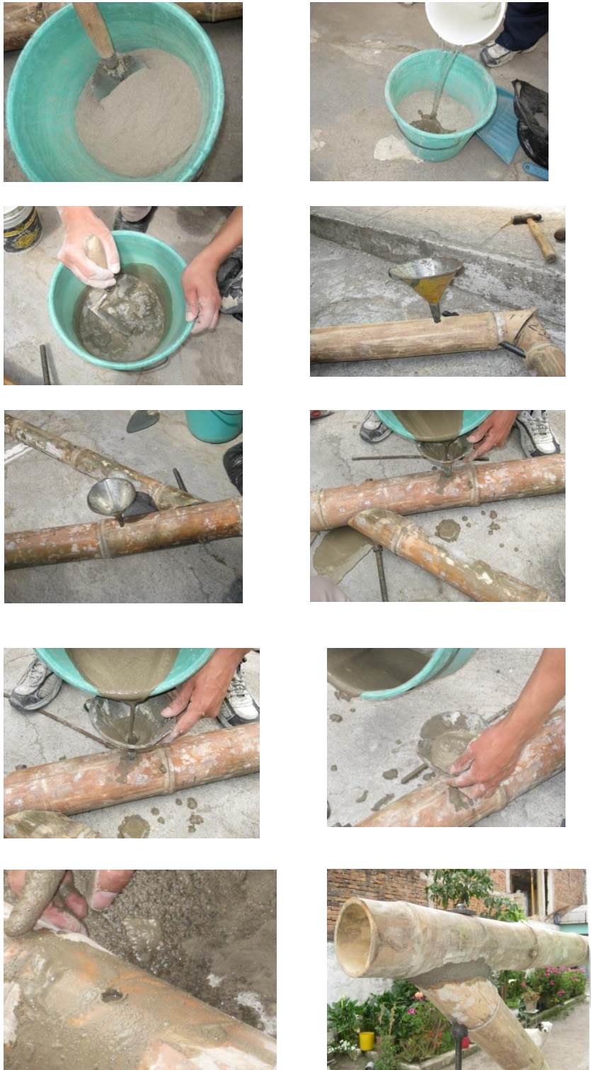
Figura 4.15: armado conexiones empernadas con mortero
