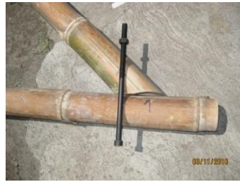
Figura 4.13: armado de conexiones pernadas
