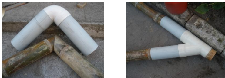
Figura 4.17: armado de conexiones con PVC
