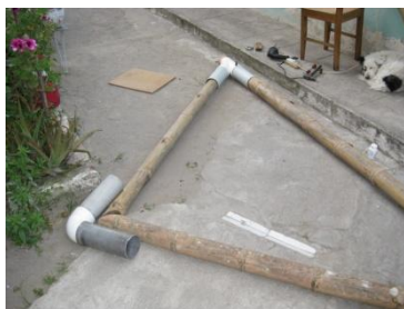
Figura 4.17: armado de conexiones con PVC (continuación)
