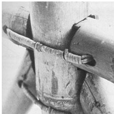
Figura 3.1 Unión amarrada con cuerda
