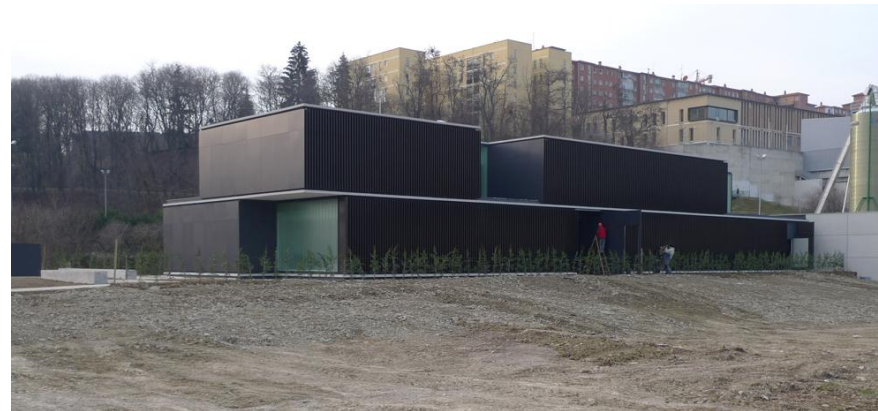
Fotografía 30 Sistema Estético- Formal Centro de Acogida Pamplona Fuente: https://www.google.com
