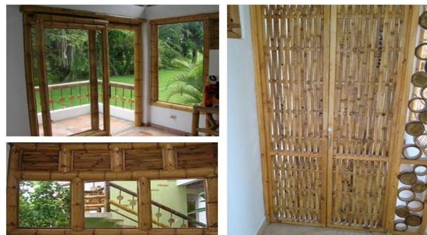
Fotografía 23 Puertas y Ventanas Bambú Fuente: www.google.com
