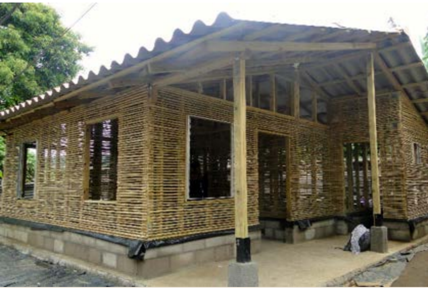
Figura 19: Casas de bahareque encementado en El Salvador (antes de aplicar el revoque de mortero)
